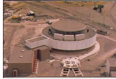
Station de pompage terminée
