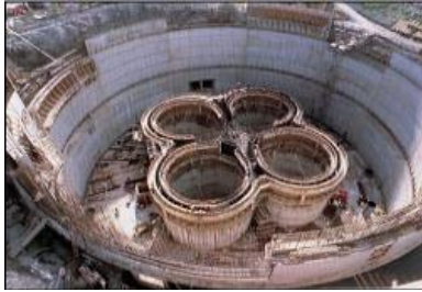
Station de pompage en construction
