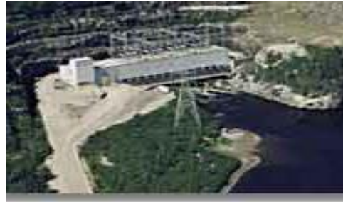
Centrale hydroélectrique Outardes 4
